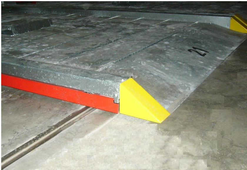
Plattform mit Auffahrbereich, Führungsschiene, Schaltleiste
